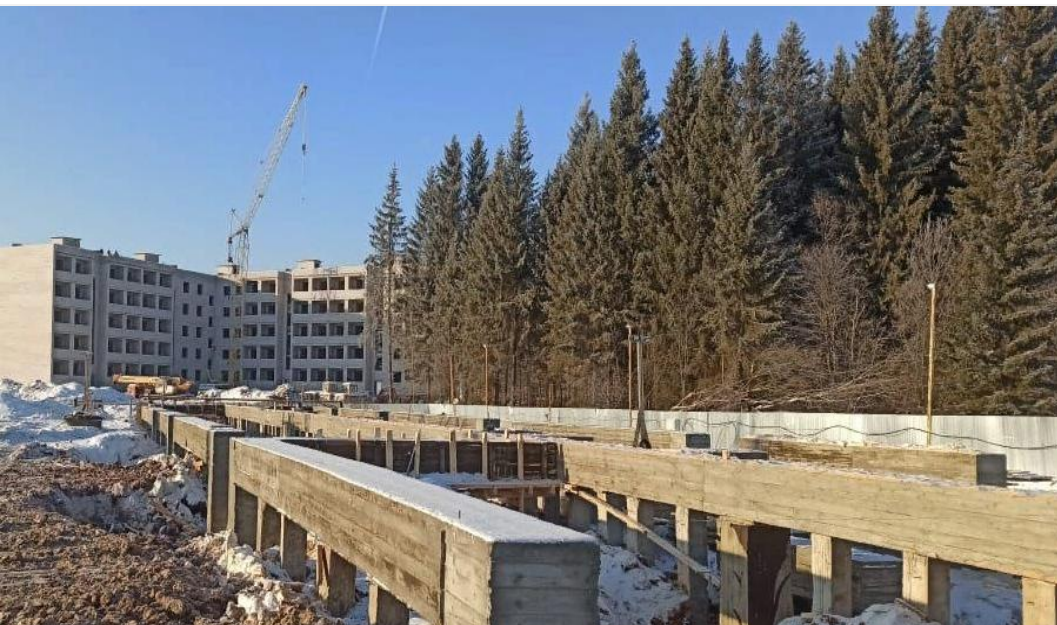
г. Котлас (2 дома)
